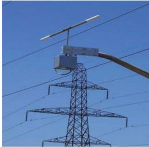
Fig. 11. ThermalRate Sensor.
